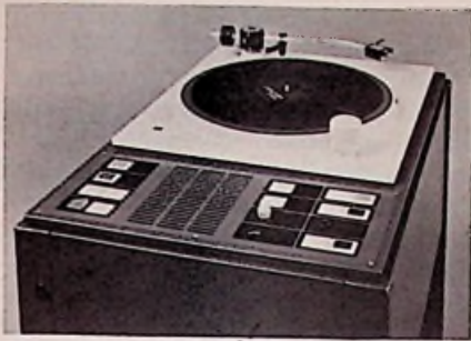
Bild 5. Schallplattler-Wiedergabe-Maschine EMT 950. Sämtliche Betriebsarten sind mit leichtgängigen Momenttasten zu wählen. Das Laufwerk-Chassis ist in der Truhe gefedert aufgehängt und gegen Störschwingungen unempfindlich
